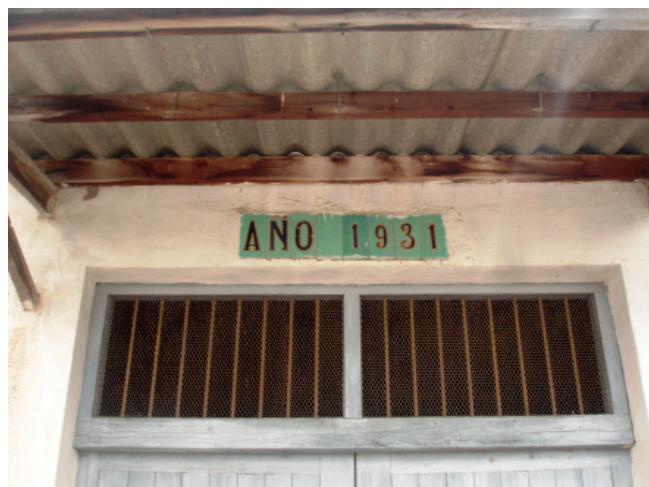
Taulells a la façana del pou de santa Quitèria de Vilamoncarro amb l'any del pou. Número 34 del present catàleg. – Azulejos en la fachada del pozo de santa Quiteria de Vilamoncarro con el año del pozo. Número 34 del presente catálogo. Fot. P. García.
