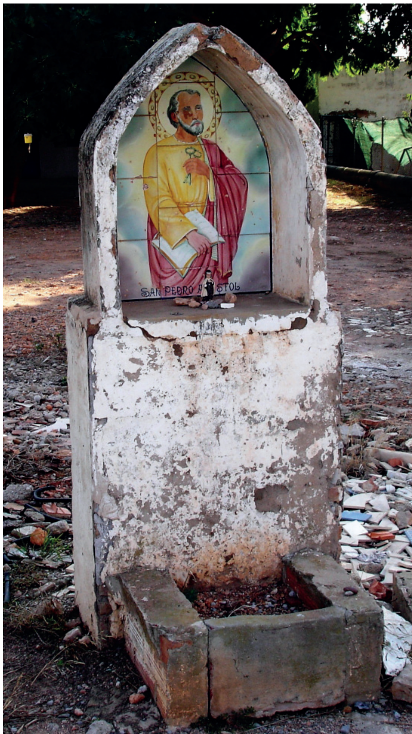
Capella exempta de sant Pere al pou de Montserrat. – Capilla exenta de san Pedro en el pozo de Montserrat. Fot. P. Garcia.
